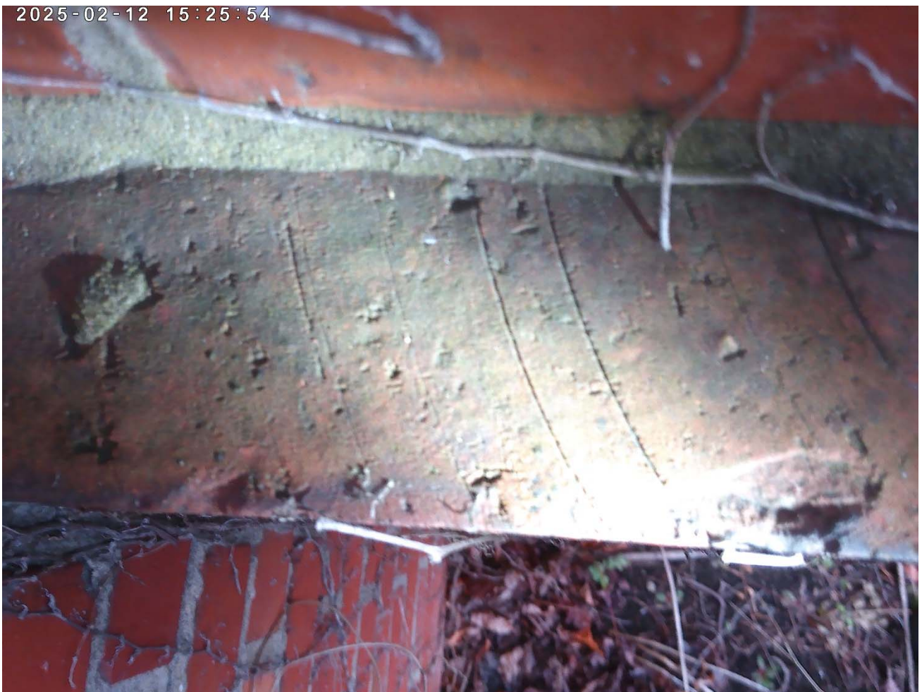
写真 3:ピアノ線の跡が弧状に遺る煉瓦
