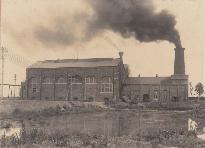
写真1:建設当時の網干工場ボイラー室
